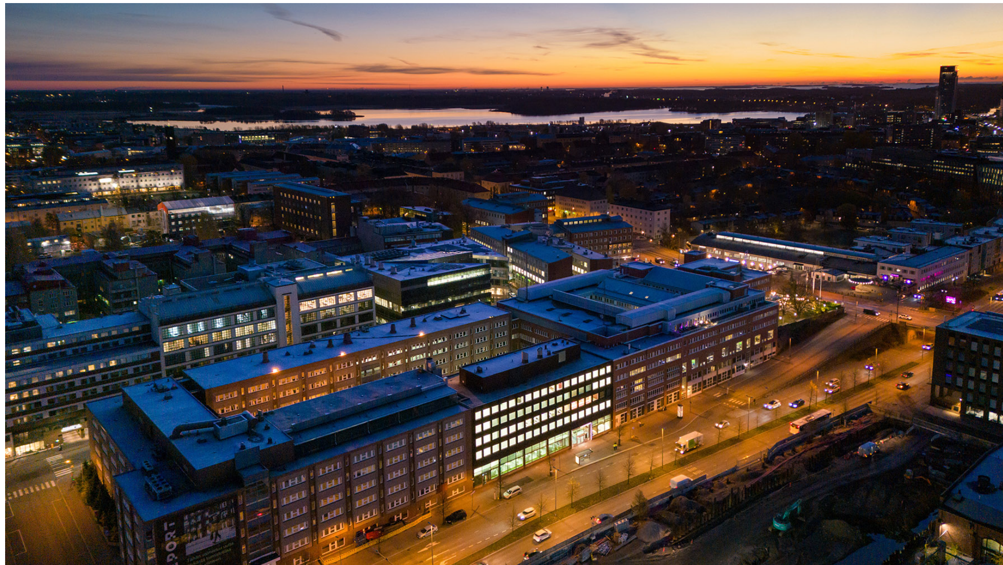
Teollisuuskatu 13 toimistotilojen saneeraus, Helsinki
